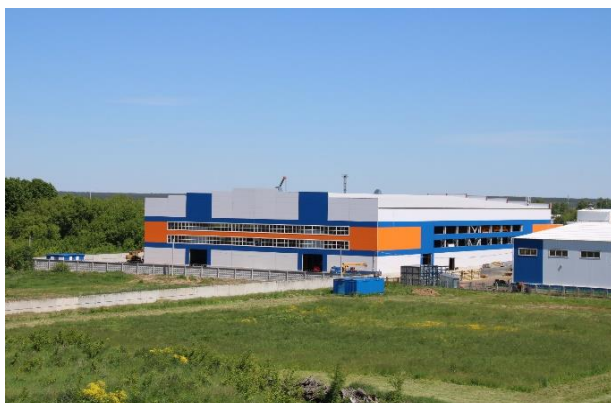
Цех по производству стальных шаровых кранов компании ADL (РФ, п. Радужный)
